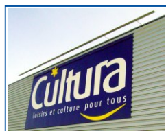
▶ Eclairage rampe lumineuse
